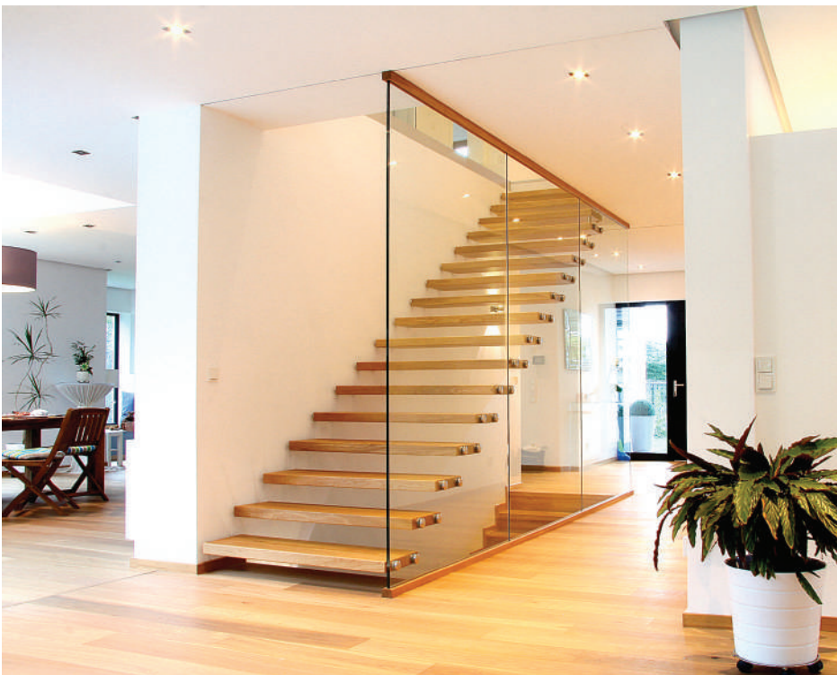
Raffinierte Kombination – das Zusammenspiel aus Holz, Glas und Edelstahl macht die Tragbolzentreppe nicht nur zu einem zeitgemäßen Bestandteil der Inneneinrichtung, sondern überzeugt auch durch Funktionalität. (Foto: epr/STREGER) 049 01
