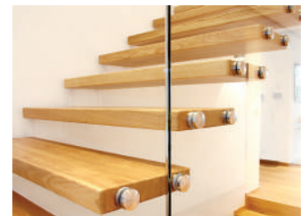
Gummigelagerte Edelstahlbolzen dämmen zum einen den Tritt beim Hinauf- und Hinabgehen der Treppe und versprühen zum anderen Eleganz und Modernität. (Foto: epr/STREGER) 049 02
