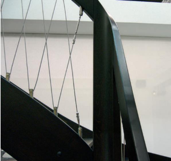
Diagonal verspannte Edelstahlseile, die mit speziellen Spannhaltern am Geländer befestigt sind, bilden die Geländerfüllung der Massivholztreppe. (Foto: STREGER/Mobirola)
